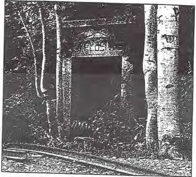
Figure 24 – Explosives Bunker, J. M. & S. Co.
