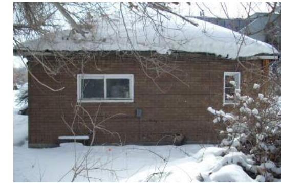
4 Existing Looking South SCALE: N.T.S.
