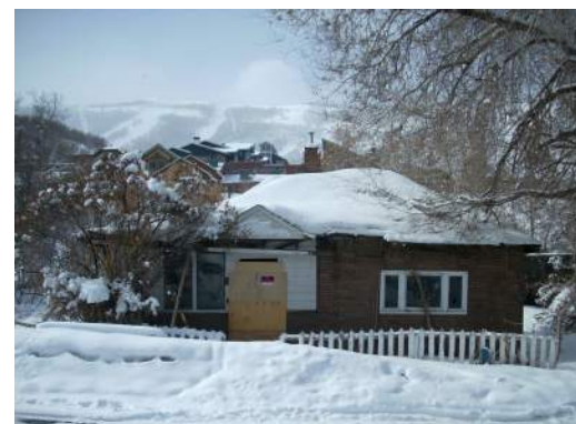
1 Existing Looking West SCALE: N.T.S.
