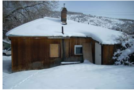
3 Existing Looking East SCALE: N.T.S.
